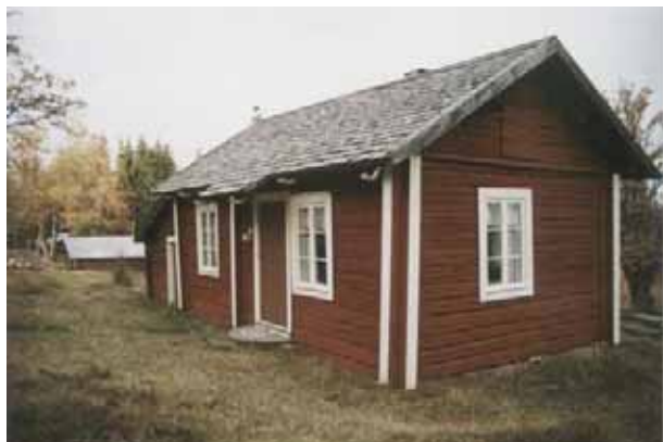
Fäbodstuga vid Gransjöberget med spåntak. I bakgrunden ekonomibyggnader.
