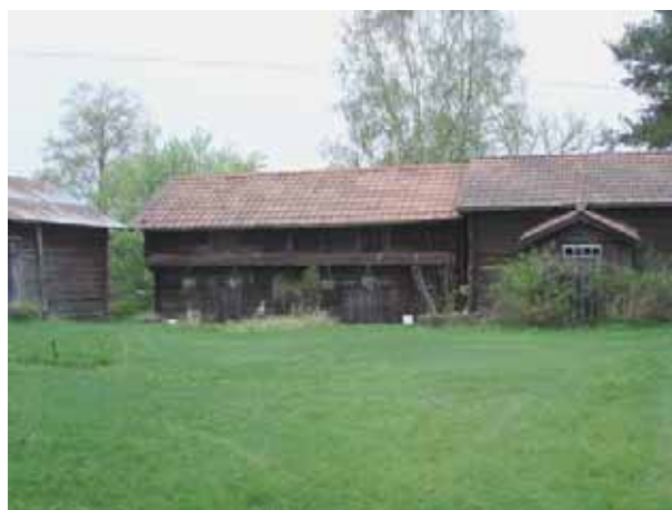
Lofgångsbyggnad på äldre gård.
