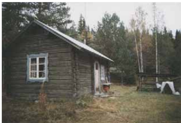
Moderniserad fäbodstuga väster om Stora Rutsberget.
