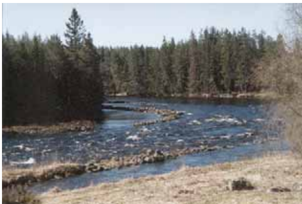
Stensträngar i älven vid Utanhed för att styra timret.
