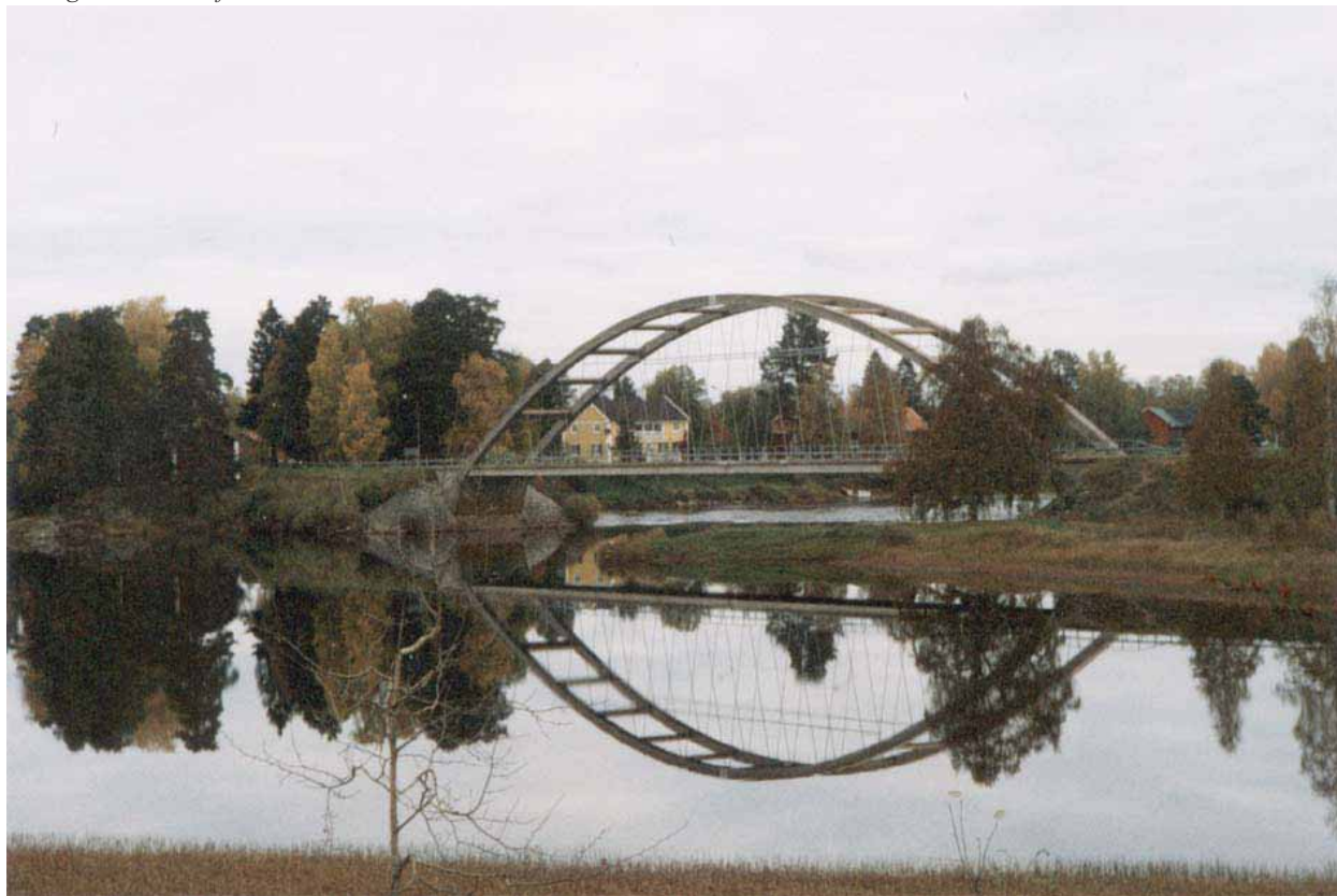
Betongbron i Järna från 1949.
