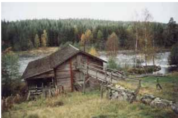
Utanheds kvarn byggdes av Josefs Lars Larsson 1869-70. Hans son och sonson drev rörelsen vidare tills verksamheten lades ner på 1940-talet. Framför ligger en såg.
