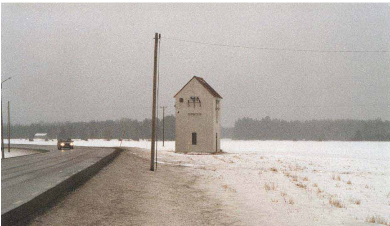
Gammal transformatorbyggnad invid riksvägen. Ett viktigt landmärke när man närmar sig Nås från väster.
