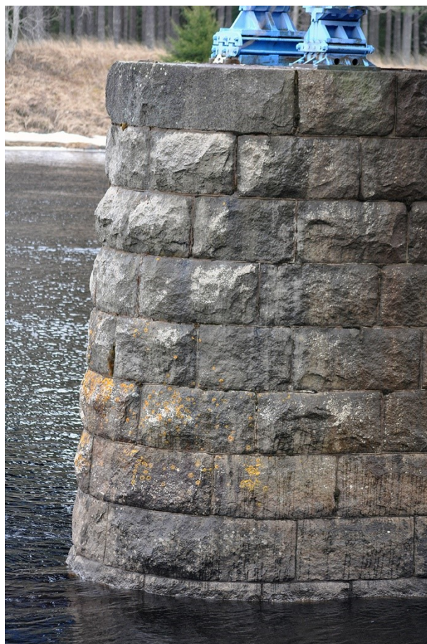
Stenkista, järnvägsbron Utanhed. Foto: H. Klingenberg
