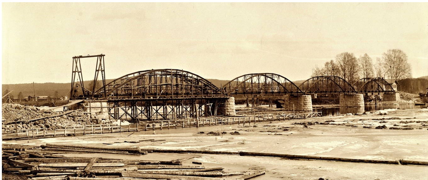
Landsvägsbron under byggnad våren 1907.
